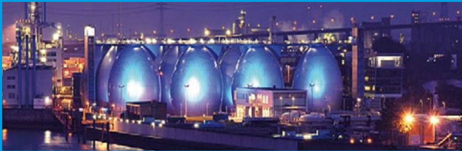
De Köhlbrandhöftcentrale bij schemering. In de blauw verlichte tanks worden grote hoeveelheden biogas aan het slib onttrokken. In de volksmond worden deze tien tanks 'de rotte eieren' genoemd. Bron: Hamburg Wasser
